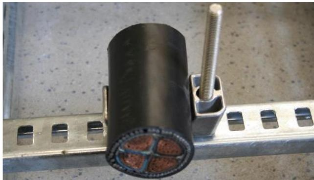
3) Coloque la otra mitad de la abrazadera. Asegure con arandela y tuerca (no suministrados) sobre la estructura de soporte y ajuste.
