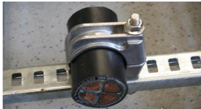
**Importante:** no apriete demasiado la abrazadera. La abrazadera debe poder sujetar el cable pero no debe estar tan apretada que los cables sobresalgan en los costados o que se incline excesivamente.
