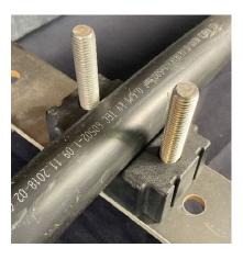
LAY THE CABLE INTO THE CLAMP. TAKE CARE TO LAY THE CABLE INTO THE CLAMP. TAKE CARE NOT DAMAGE THE CABLE.
