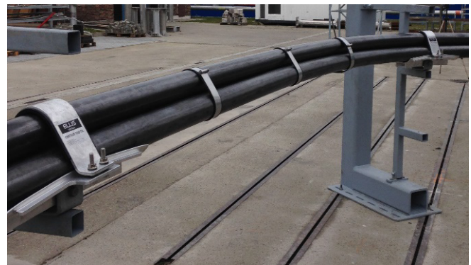
FOTO DE LA INSTALACIÓN DE PRUEBA DE CORTOCIRCUITO PARA CENTAUR TREFOIL. LA PRUEBA SE LLEVÓ A CABO EN LOS LABORATORIOS ZKU DE PRAGA, REPÚBLICA CHECA.
