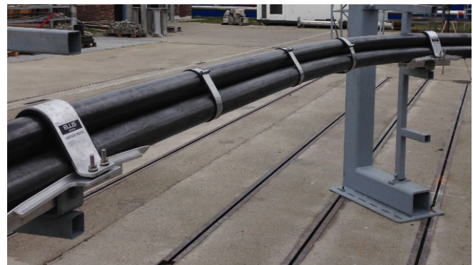
EIN FOTO DES KURZSCHLUSSPRÜFSTANDES FÜR CENTAUR DREIPASS. DIE TESTS WURDEN IN DEN ZKU-LABORATORIEN IN PRAG, CZ, DURCHFÜHRT.
